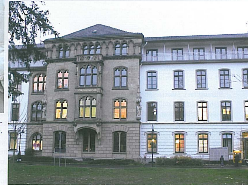
Von der Kölnstraße aus hat man jetzt freien Blick auf das Gesundheitszentrum. Die Mauer, die das Gelände jahrzehntlang abschirmte, ist dem Bagger zum Opfer gefallen. Fotos: hf
